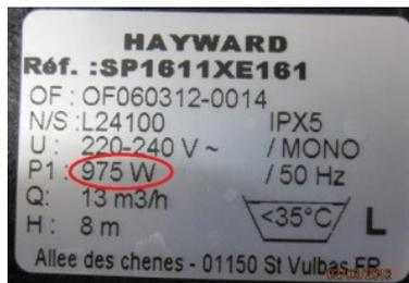
FIGURE 1.9 – Plaque signalétique d'une pompe
