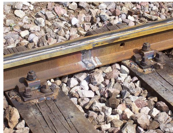
FIGURE 1.2 – Exemple de soudure entre deux rails (d'après wikipédia)
