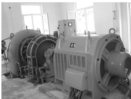
FIGURE 4 – Génératrice électrique à gaz
