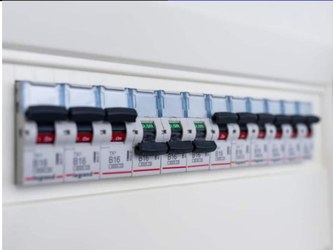
Figure – Tableau électrique contenant des disjoncteurs (norme NFC 15-100)
