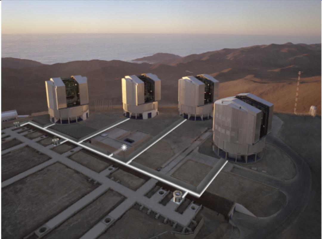
**Figure** – Principe de superposition des faisceaux lumineux du Very Large Telescope Interferometer sur le site de Cerro Paranal (désert Chilien). *D'après ESO.org*
