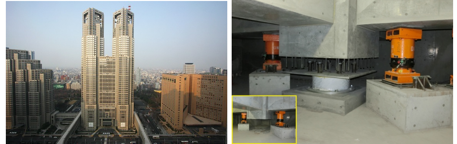
FIGURE 31 – Tour du Tokyo Metropolitan Government (243 m) et ses absorbeurs de chocs. D'après https://resources.realestate.co.jp .
