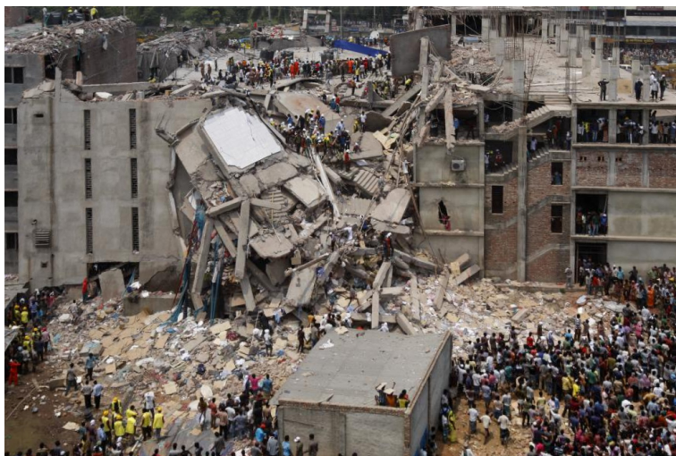
FIGURE 18 – L’effondrement du Rana Plaza est l’effondrement d’un immeuble à Savar, faubourg ouest de Dacca, la capitale du Bangladesh source Wikipédia
