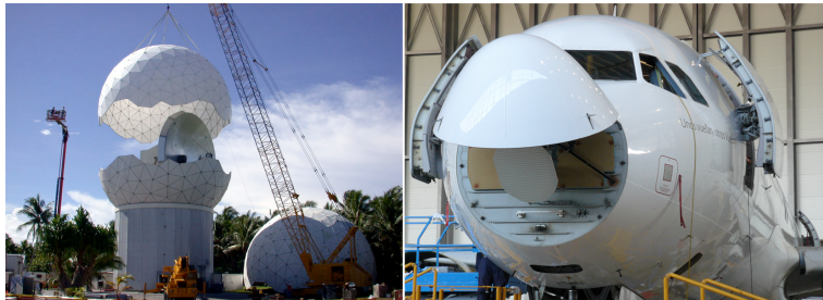
FIGURE 36 – a) Installation d'un radôme pour une antenne de réception satellite. b) Radôme en forme de cône qui une fois soulevé montre le radar d'un Airbus A320.
