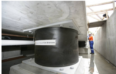
FIGURE 1 – Friction Base isolator : système parasismique (d'après https://www.readymadeseminar.com/2015/06/base-isolation.html )
